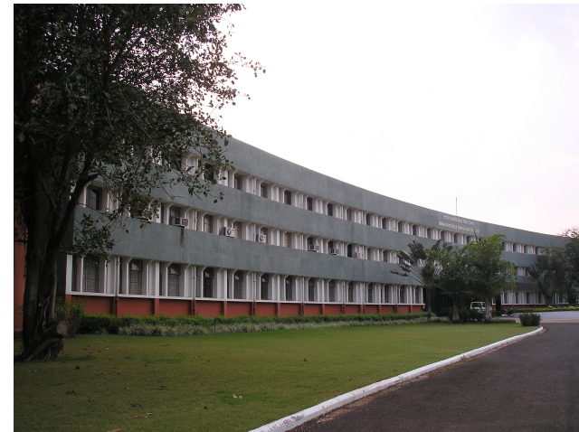
Bâtiment principal de l'IITM
